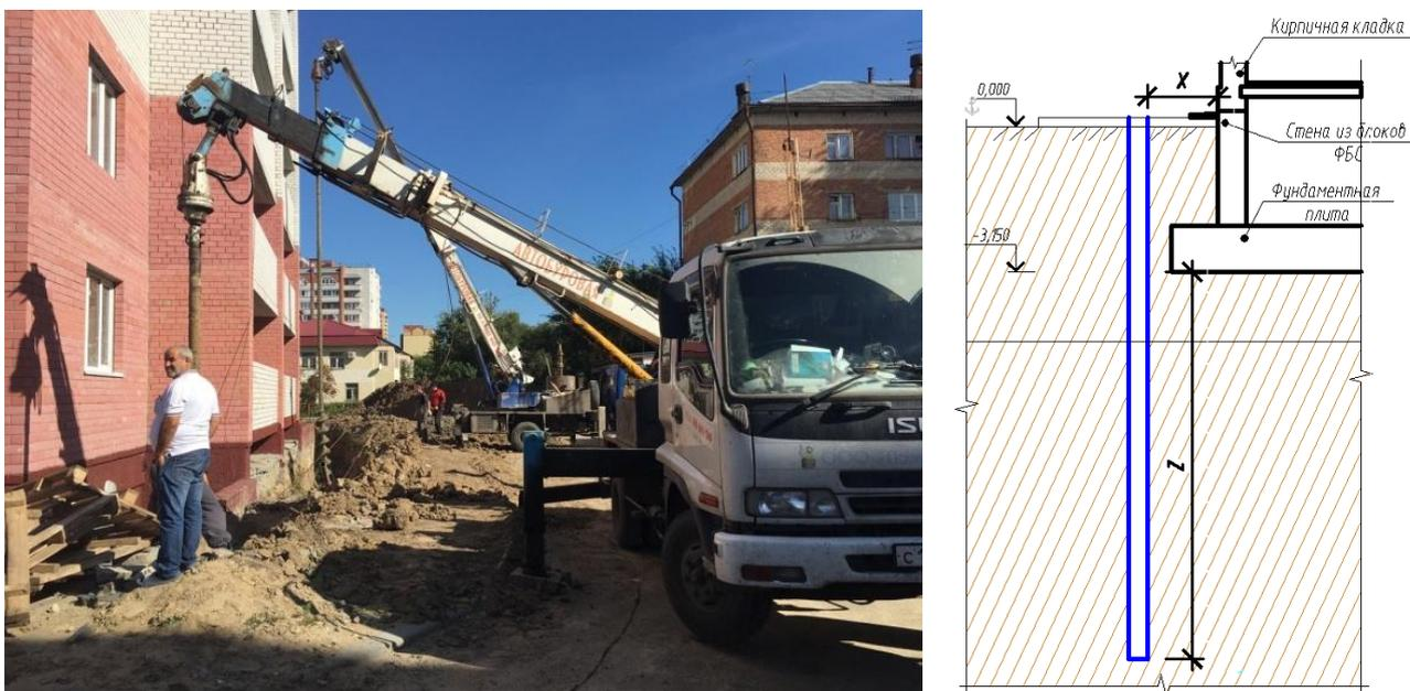
**Рисунок 4.12** – Работы по выбуриванию скважин
