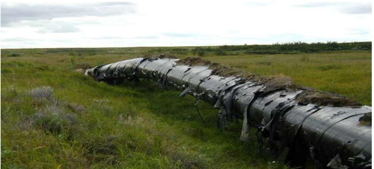
Рисунок 1.2.3 – Образование арки выброса на линейной части действующего газопровода вследствие пучения грунта
