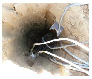
**Рисунок 4.7.** Проектное положение внедренных мессдоз
