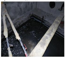
**Рисунок 4.8.** Профилированная мембрана «Planter»
