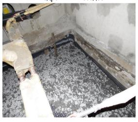
**Рисунок 4.9.** Укладка щебеночного слоя толщиной 100 мм
