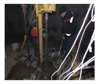
**Рисунок 4.6.** Бурение скважины для установки подготовленных мессдоз
