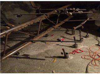
**Рис. 4.18.** Устройство реперной системы для измерения осадок фундаментов и послойных деформаций грунта
