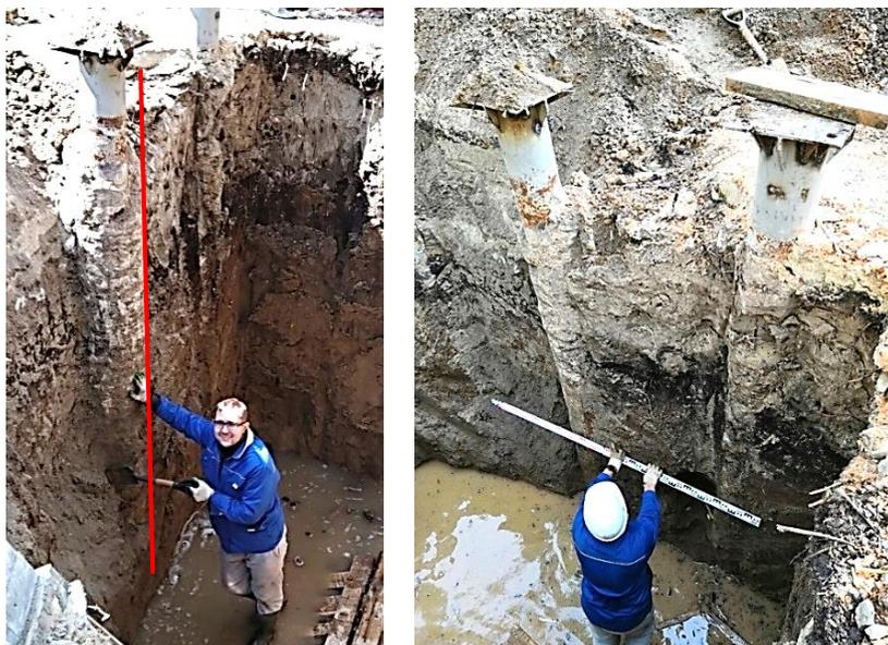
**Рисунок 3.18.** Обследование свай в процессе откопки.
