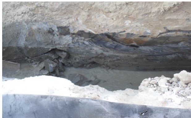
Рисунок 2.36. Скопление воды в разработанной траншее, образовавшееся за счет фильтрации на границе основание – земполотно
