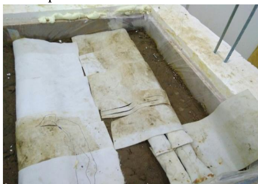
Рисунок 4.31. Устройство в нижней части земполотна теплоизоляционного материала в водонепроницаемой геомембране
