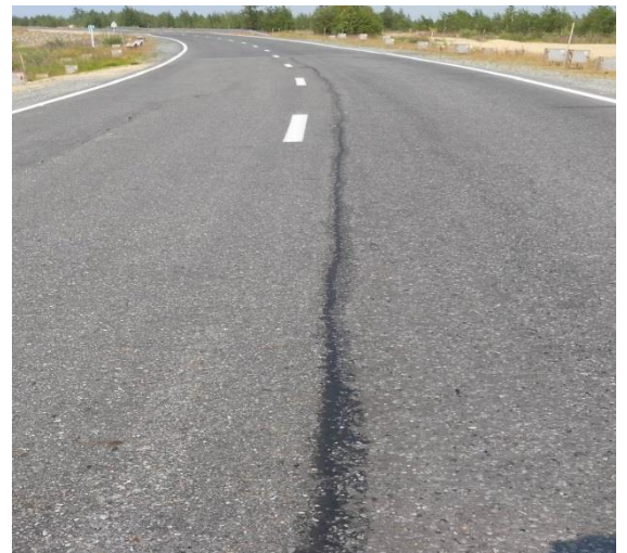
Рисунок 2.45. Трещина на покрытии вдоль оси дороги по середине проезжей части с максимальной величиной раскрытия \Delta 30 мм, длина трещины L = 30 , м (ПК597+17,50 – ПК597+42,50)
