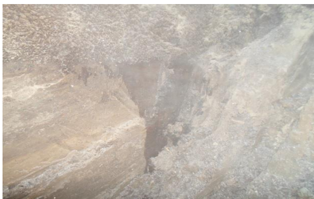
Рисунок 2.34. Фильтрация воды через уплотненный торфяной слой на границе «основание-земполотно»
