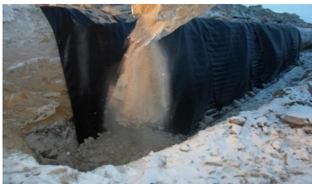
Рисунок 2.20. Обратная засыпка траншеи выработанным грунтом
