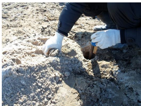
Рисунок 2.26. Погружение грунтовой марки, заполнение скважины песком
