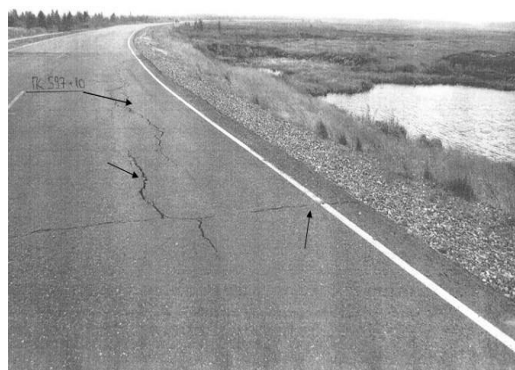
Рисунок 2.17. Развитие деформаций на экспериментальном участке
