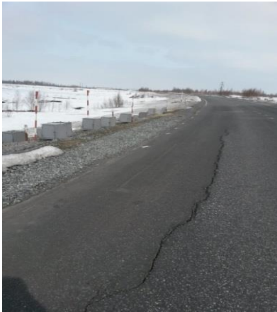
Рисунок 2.46. Трещина на покрытии вдоль оси дороги посередине проезжей части с максимальной величиной раскрытия \Delta 50 мм, длина трещины L = 18,45 м (ПК597+25 – ПК597+42,50)
