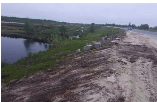
Рисунок 2.33. Общий вид экспериментального участка с установленным контрольно-измерительным оборудованием
