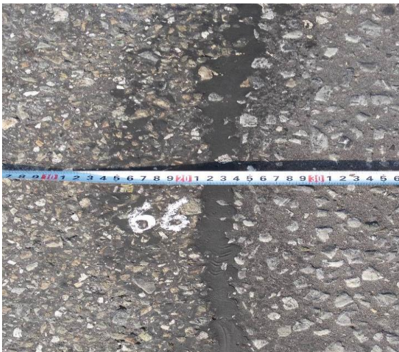
Рисунок 2.45. Трещина на покрытии вдоль оси дороги по середине проезжей части с максимальной величиной раскрытия \Delta 30 мм, длина трещины L = 30 , м (ПК597+17,50 – ПК597+42,50)
