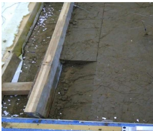
Рисунок 4.23. Профилировка откоса
