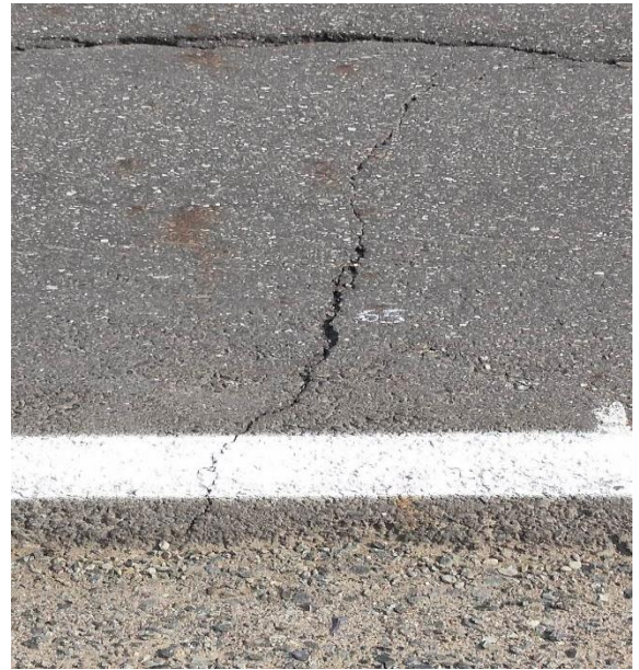
Рисунок 2.44. Трещина на проезжей части поперек оси автомобильной дороги (ПК597+23,70) с максимальным раскрытием \Delta 35 мм, длина трещины L = 2,31 м
