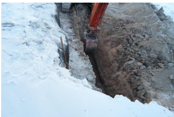
Рисунок 2.19. Разработка продольной траншеи
