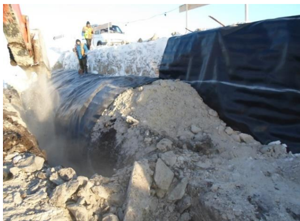
Рисунок 2.21. Размещение армирующего элемента
