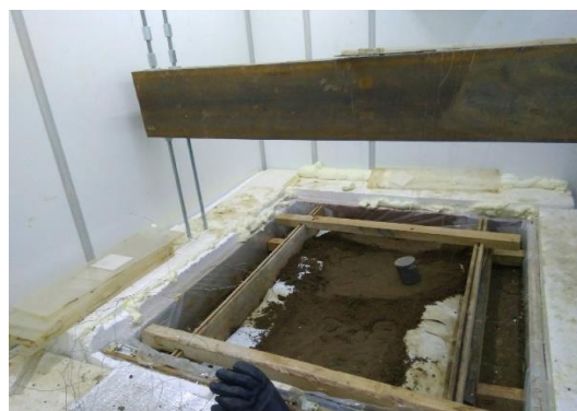
Рисунок 4.32. Монтаж опалубочной конструкции и послойное устройство земполотна
