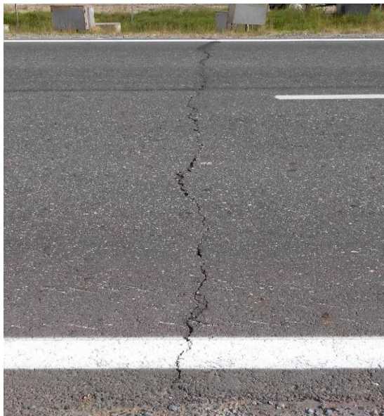
Рисунок 2.47. Трещина на проезжей части поперек оси автомобильной дороги (ПК597+33) с максимальным раскрытием \Delta 40 мм, длина трещины L = 9,30 м
