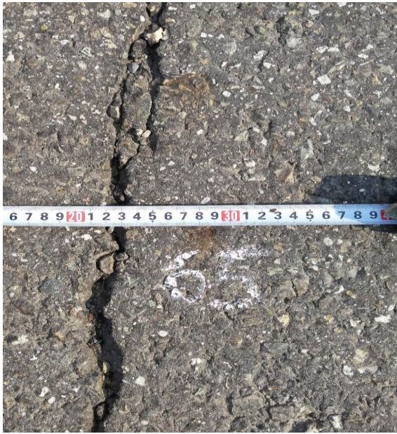
Рисунок 2.44. Трещина на проезжей части поперек оси автомобильной дороги (ПК597+23,70) с максимальным раскрытием \Delta 35 мм, длина трещины L = 2,31 м
