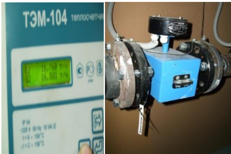
Рисунок 3.3 - Тепловой счетчик ТЭМ-104 с преобразователем расхода ПРП-Ду-80
