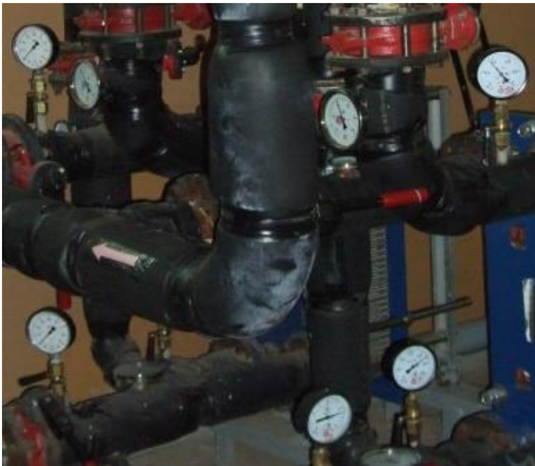
Рисунок - 3.5 Показывающие манометры избыточного давления и термометры
