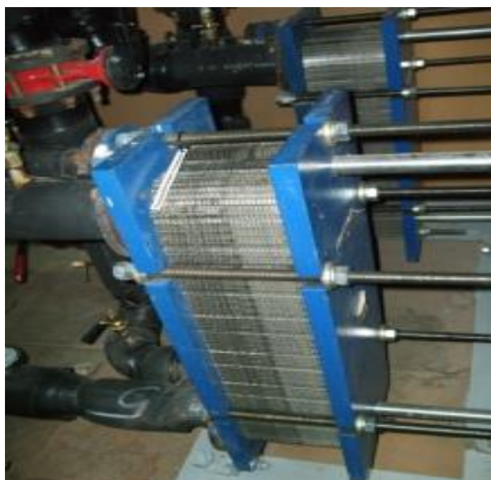
Рисунок 3.2 - Теплообменники производства фирмы «Функе - Тюмень»
