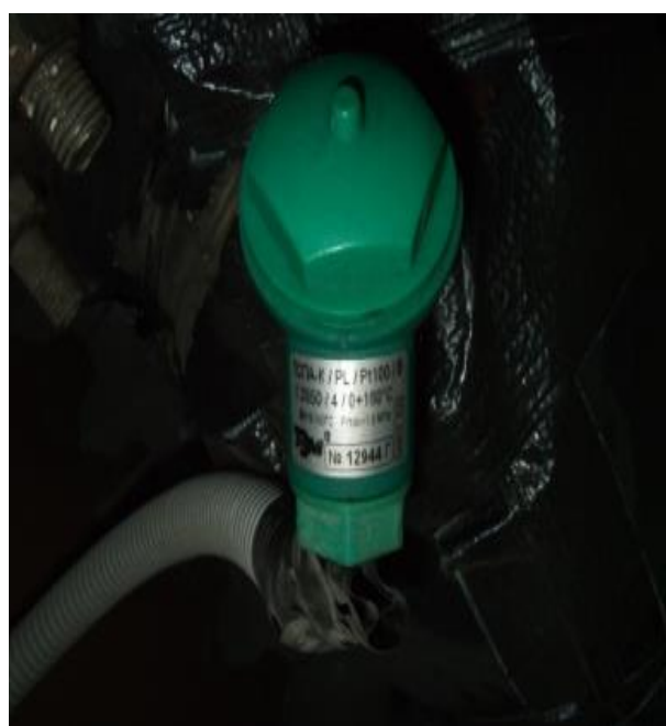
Рисунок - 3.4 Термодатчик ТСПА-К/PL/Pt100/B1.3850/4/0+160°C
