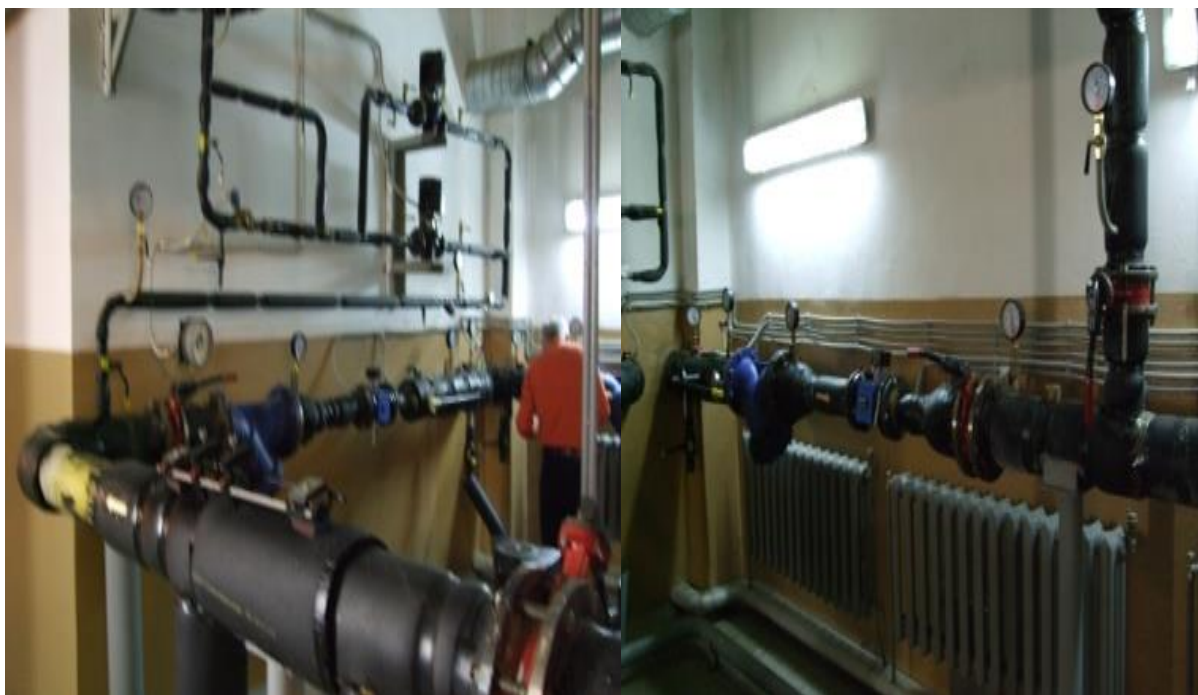
Рисунок 3.1 - Трубопроводы, запорная и регулирующая арматура
