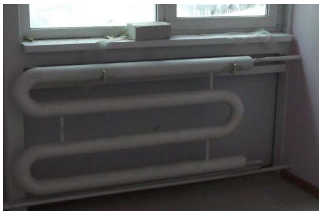
Рисунок 3.3. Гладкотрубный отопительный прибор
