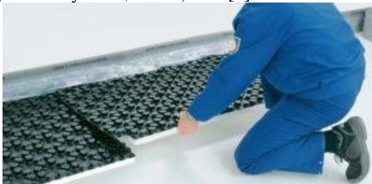
Рисунок 1.2. Укладка теплоизолятора
