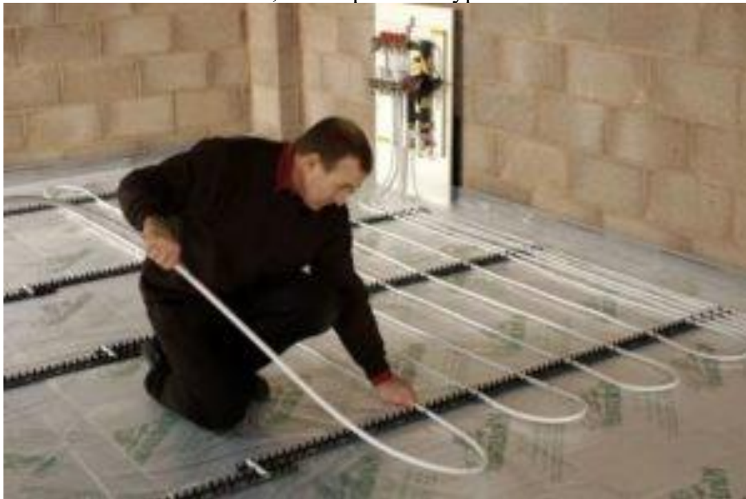
Рисунок 1.1. Укладка теплого пола
